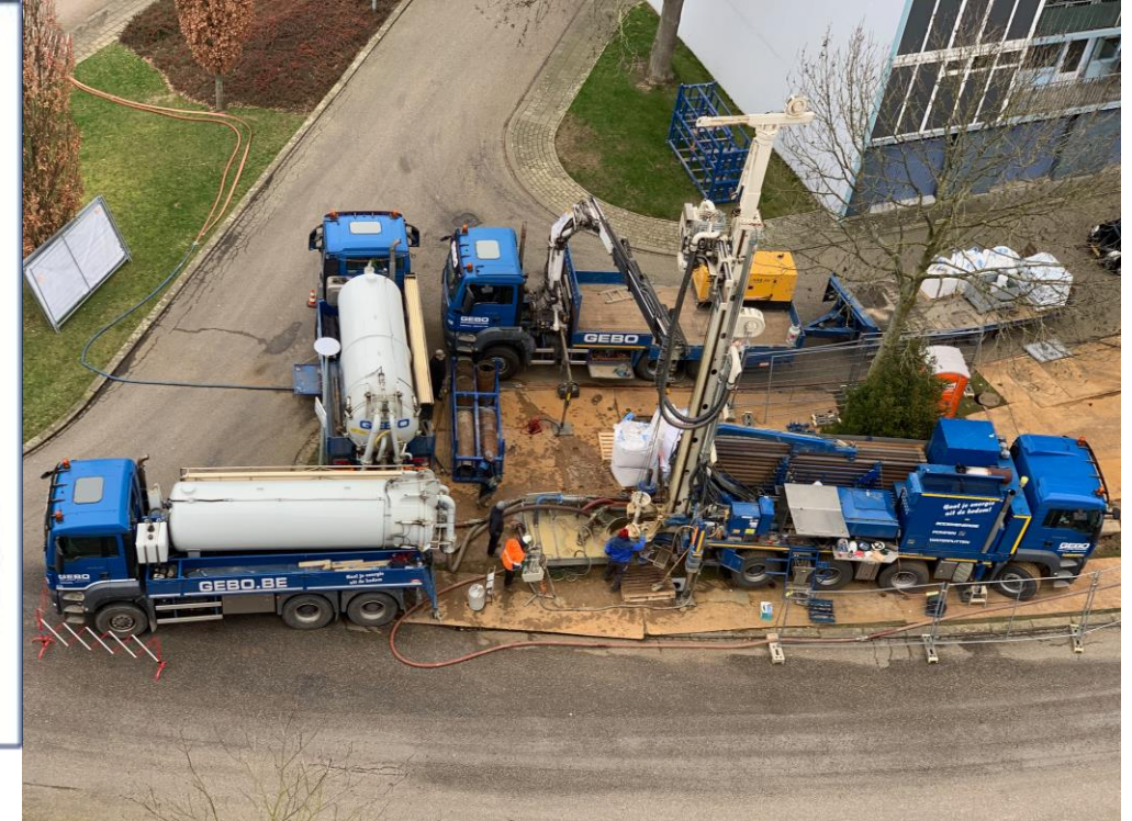
Voorbeeld booropstelling WKO-bron met bovengrondse afwerking [bron: GEBO (B)]
