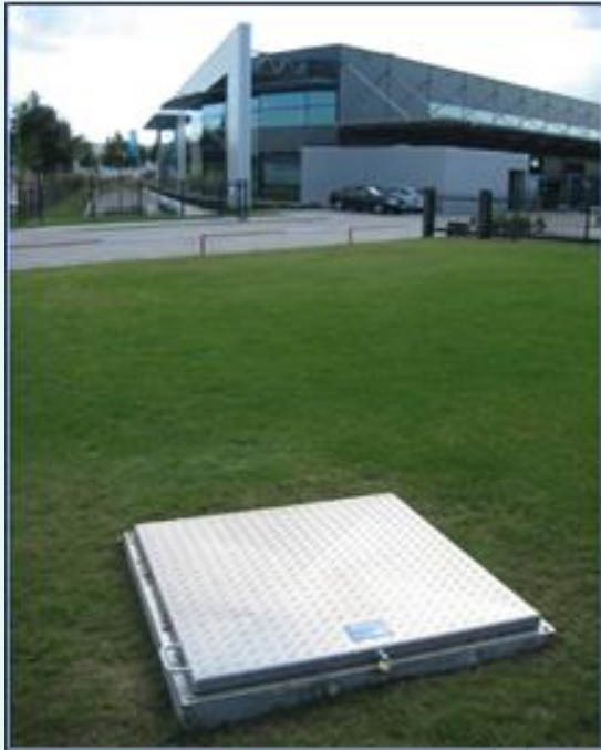
Voorbeeld booropstelling WKO-bron met bovengrondse afwerking [bron: GEBO (B)]
